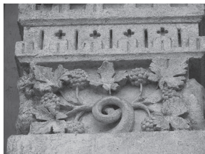
図版 5 最後の審判の門，玄関柱（部分）
