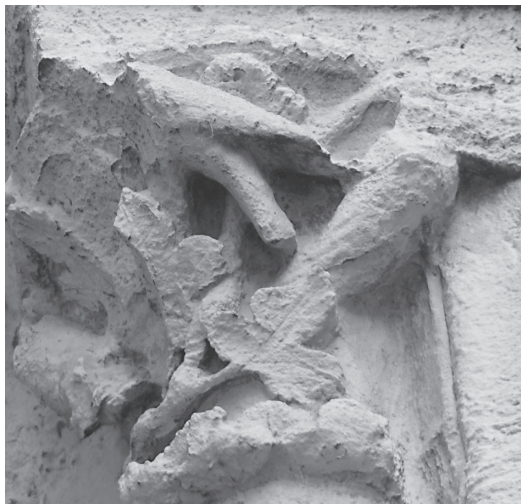
図版8 南袖廊玄関右側柱頭
