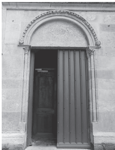
図版 6 南袖廊玄関
